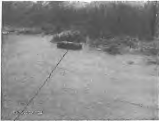
Photograph 2 – Headwall Tý Du Road
